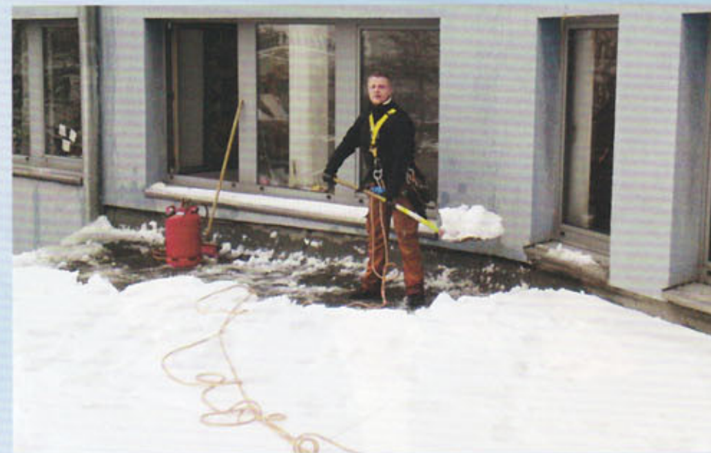
Schaufelt Schnee: Michael Storch, Mitarbeiter der Firma Industriekletterer-Hannover, befreit ein Flachdach im Medienzentrum von der Schneelast.
