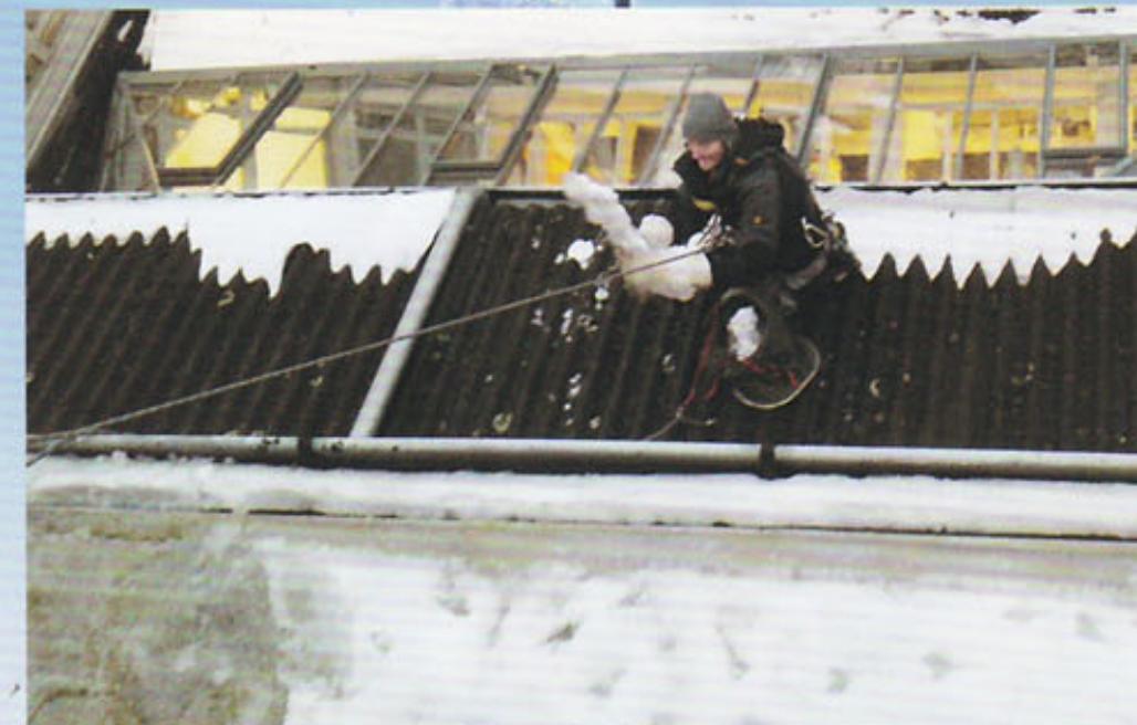
Weg mit dem Eis: Nachdem herunterrutschende Eisschollen bereits Glasscheiben des Daches der Hitradio Antenne-Redaktion im Medienzentrum beschädigt hatten, holte Hausmeister Josef Jover den Industriekletterer Thomas Krohn zu Hilfe. Der befreite die Dachkante vom Eis.
